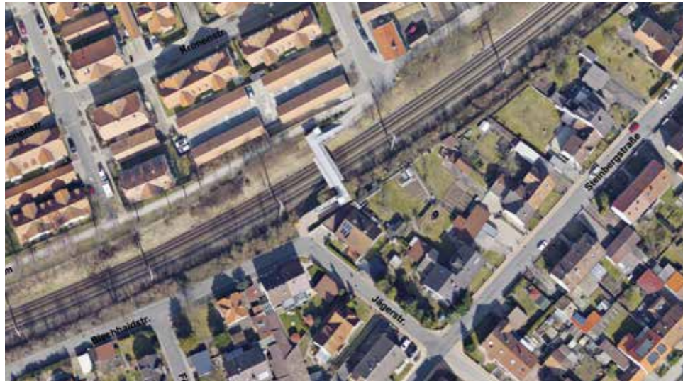
Luftbild Fußgängersteg Grabenstraße/Blech- haidstraße, 2016
