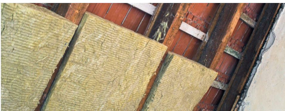
Wärmedämmung von innen: Zwischensparrendämmung
